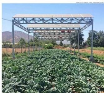
Los paneles son colocados a una altura y posición que permiten el paso necesario de luz solar al cultivo e incluso el uso de maquinarias.
